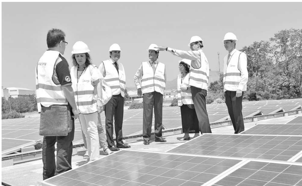
Autoridades y representantes de Transmediterránea, Acciona y Ruiz de Velasco, junto a la nueva instalación.
